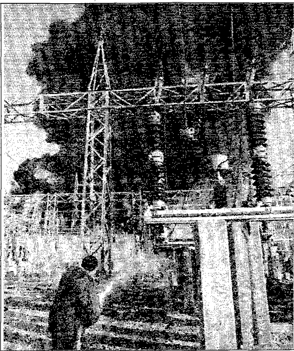
محطة الكهرباء الرئيسية التي دمرها القصف الإسرائيلي جنوبي بيروت.
